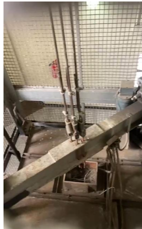
Figura 2 – Cabos de tração do elevador
