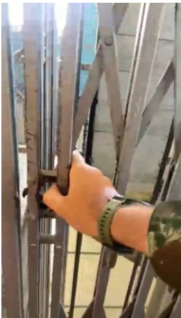
Figura 3 – Porta pantográfica de acesso do elevador
