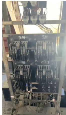
Figura 4 – Quadro de comando de bobinas e relés
